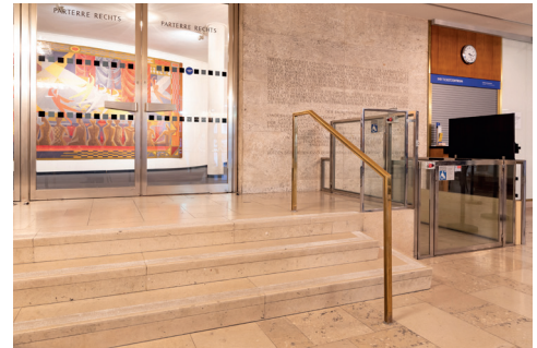
Hebebühne und Stufen zum Parterre HAUS EINS
