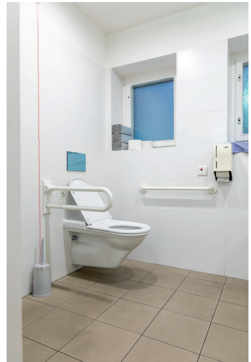
barrierefreies WC HAUS ZWEI
