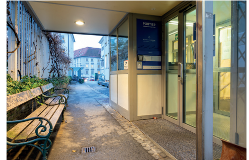
Eingang HAUS ZWEI
